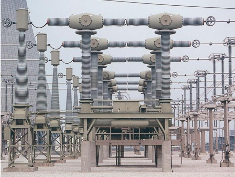
**Figura 5.4** Ejemplo de rompedor de chorro de aire (Foto: Cortesía: Georgia Power Co.)
